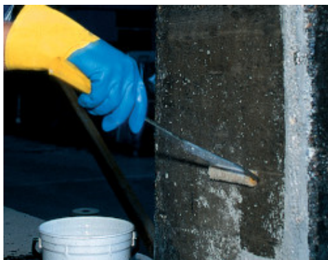
Påføring af MapeWrap 31 med en rulle på den stadig friske MapeWrap 11 (eller MapeWrap 12)
