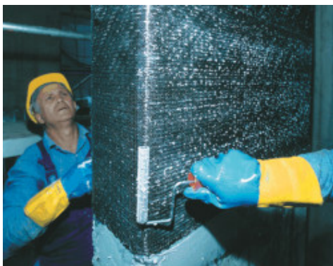
Tryk på dugen med MapeWrap-rullen, så MapeWrap 31 kan trænge godt ind i dugen.
